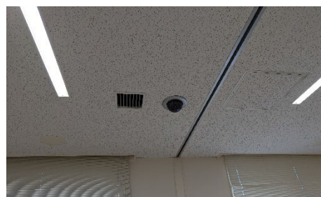
OSCE 室 天井カメラ
