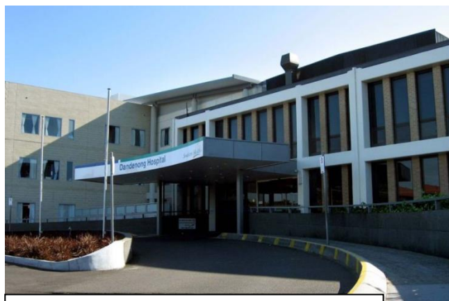
写真 1. Dandenong Hospital の外観
