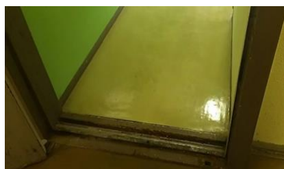
3) 監置室の二重扉の跡
